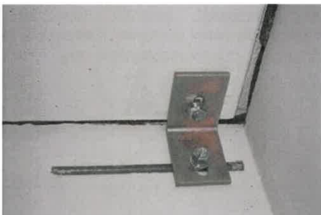
Kątownik łączący korpus z dachem
